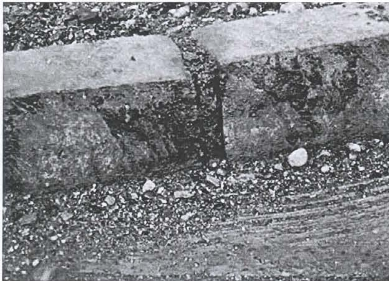
Fotografía N° 9: Emboquillado incompleto o con terminación deficiente. (Calle Freire, Tramo II, cercano a esquina con Alfonso Serrano)
