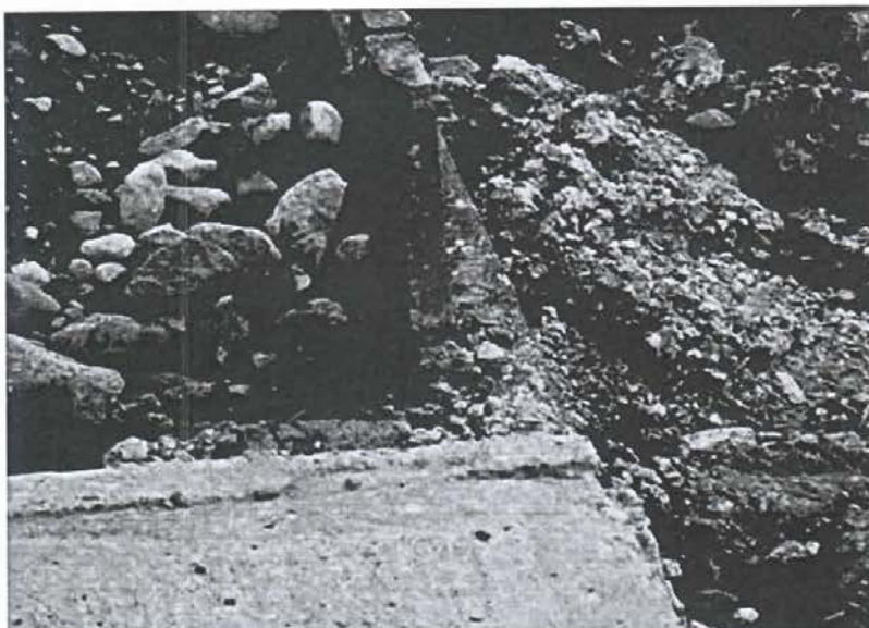
Fotografía N° 22: Uso de moldajes y estacas de madera. (Calle Freire Tramo I)
