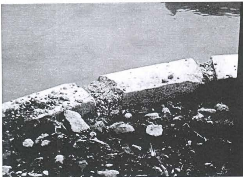
Fotografía N° 18: Soleras de largo menor a 0,45 m instalada en cruce de calles con radio de curva menor a 10 m, sin bordes aserrados. (Esquina calles Max Casas con Lautaro)
