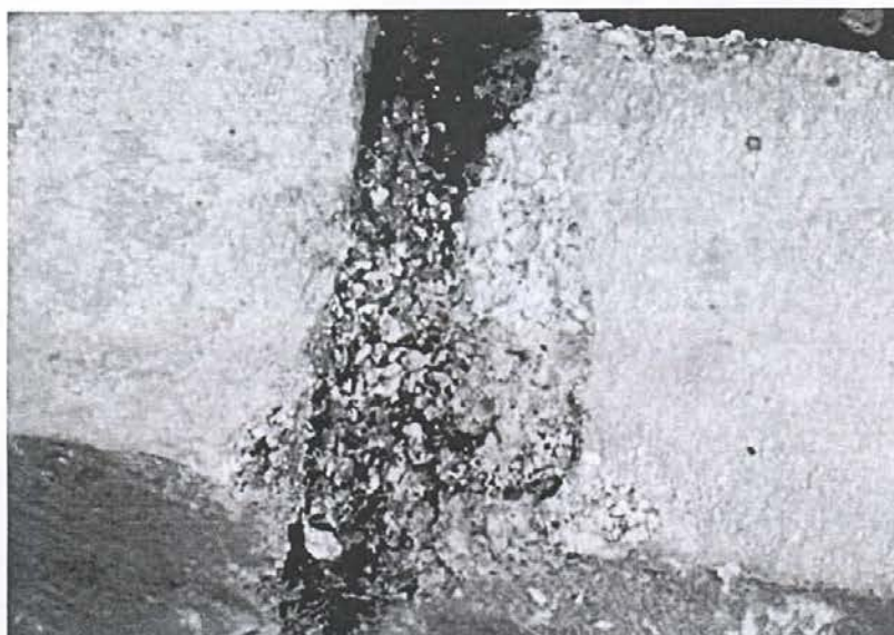
Fotografía N° 16: Soleras con despuntes. (Calle Freire, Tramo II)
