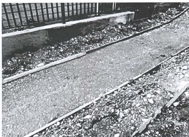
Fotografía N° 22: Uso de moldajes y estacas de madera. (Calle Freire Tramo I)
