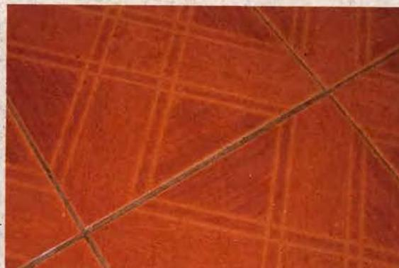
Fotografía N° 8: Fisura en pavimento.
